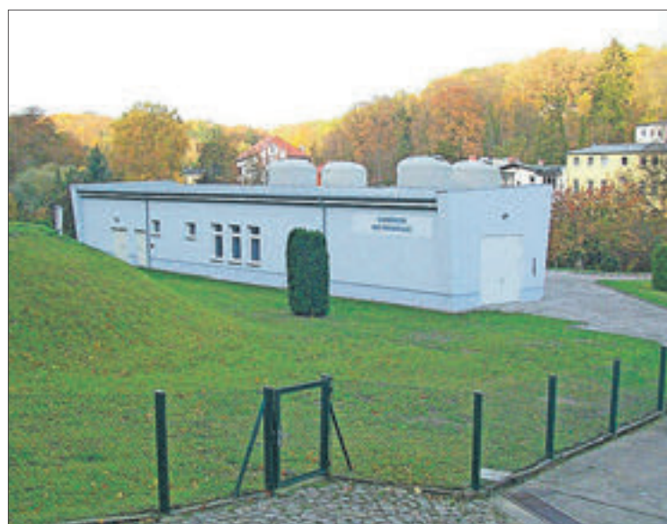
Das Wasserwerk Bad Freienwalde wurde in den Jahren 2004 bis 2006 kernsaniert und verfügt über modernste Technik. Es ist das größte Wasserwerk des Verbandes.
