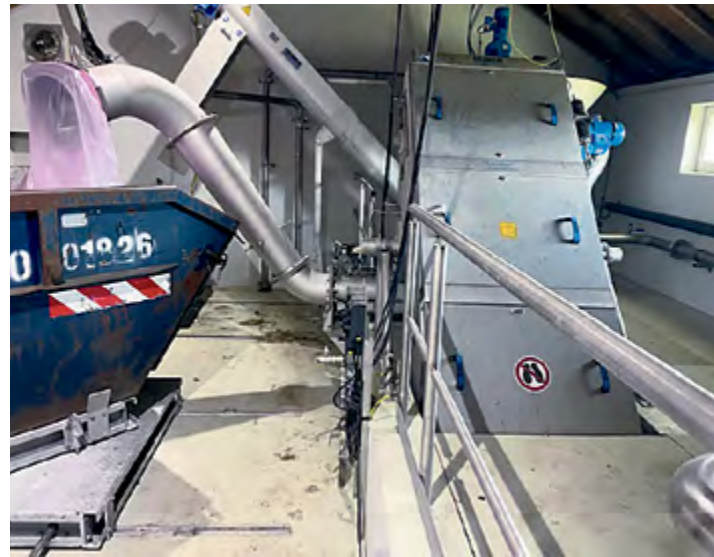
Der alte Doppelrostfeinrechen wurde durch einen Harkenumlaufrechen ersetzt. Foto: TAVOB
