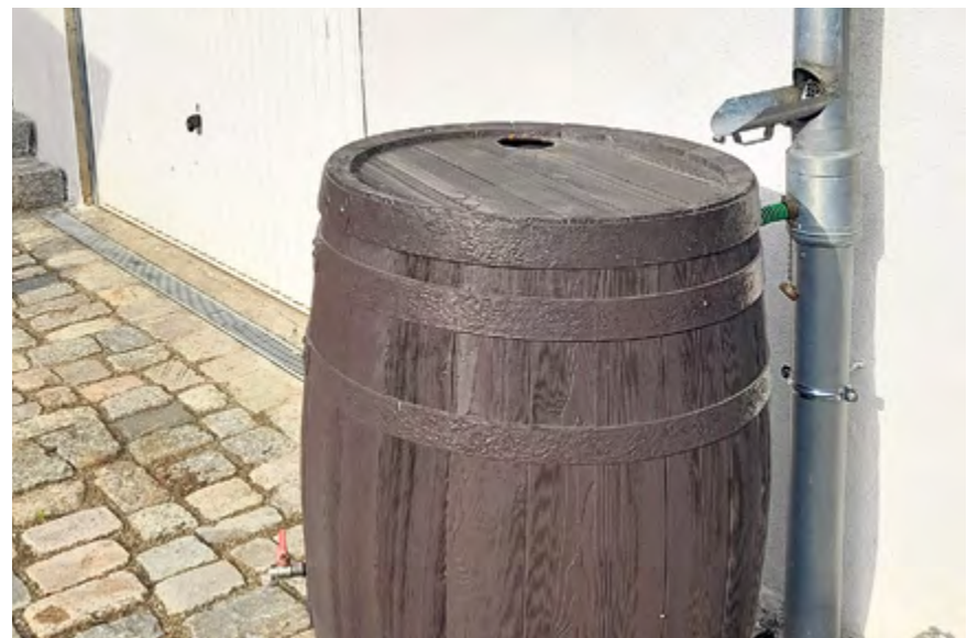
Angesichts zunehmender Trockenheit ist aufgefangenes Regenwasser sehr wertvoll. In die Kanalisation darf es nicht eingeleitet werden. Eine clevere Armatur – umgangssprachlich „Regendieb“ genannt – zweigt am Fallrohr den Niederschlag ab und leitet ihn in die Aufangbehälter.
